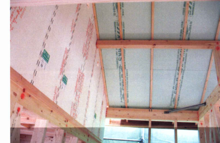
下屋での屋根パネル
