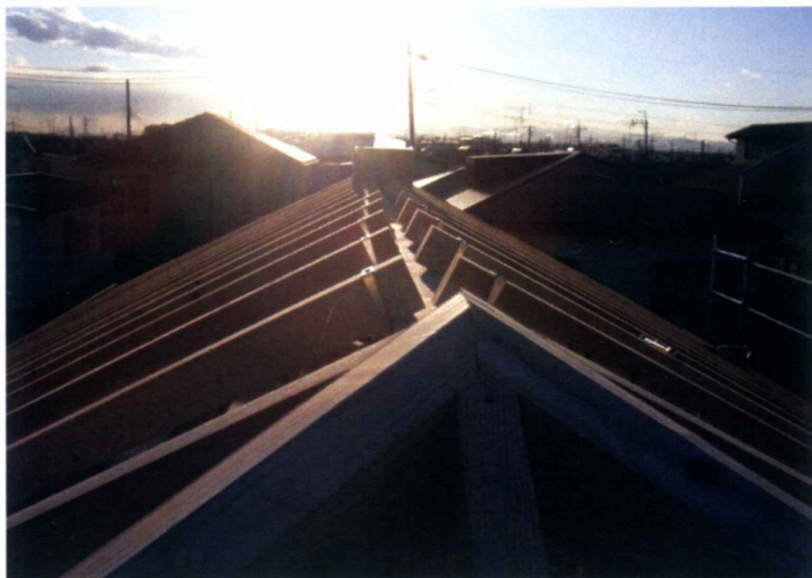
日没の早い2月上旬上棟日。これからのパネルの建込み。日没時完了。
