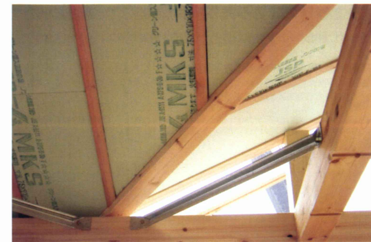
谷木と屋根パネル
